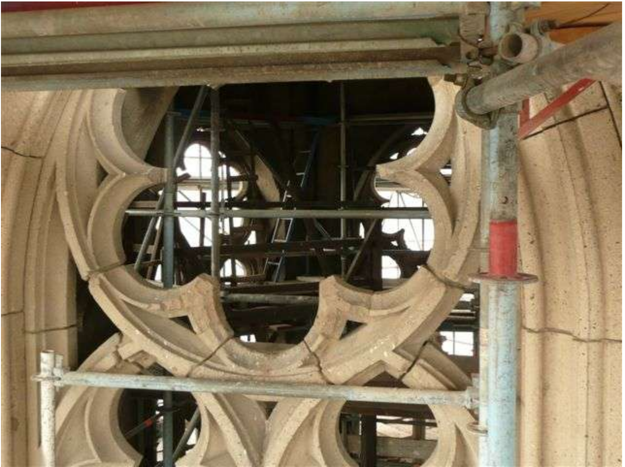
Blick von außen in die Turmkammer
